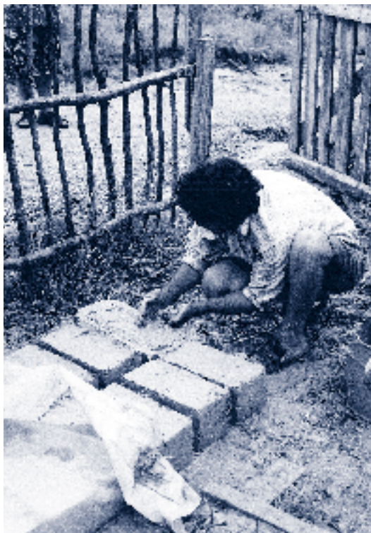
Obr. 17 – Výroba nepálených cihel – valků. Krásnohorské Podhradie, 1999.
